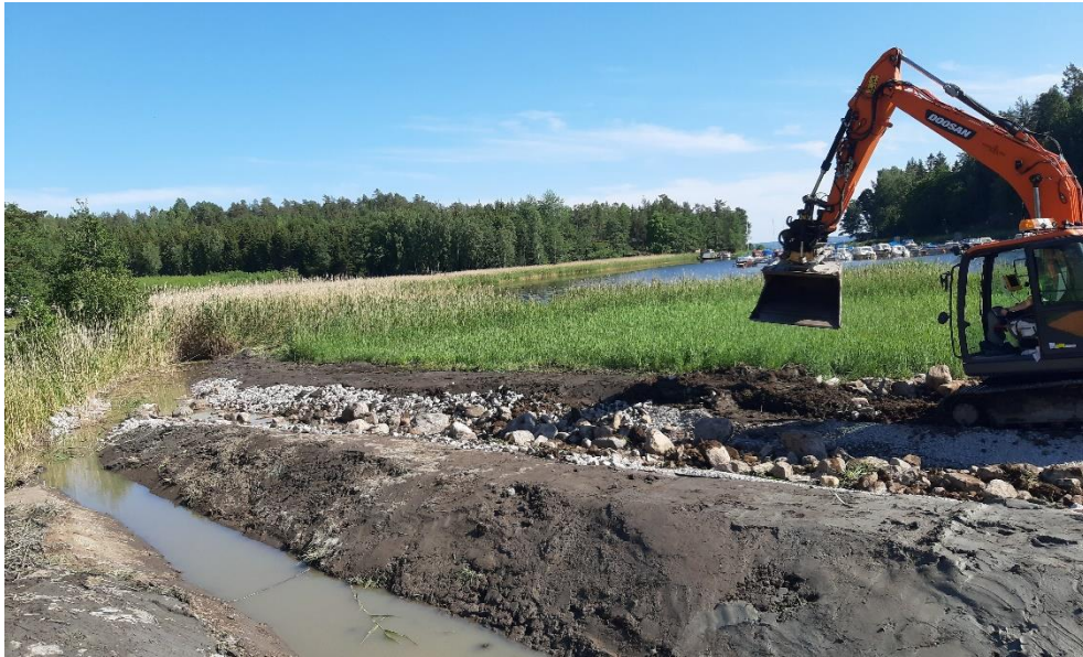
Figur 15. Stenkrossen kläddes in med natursten för att skapa en naturlig bäckfåra med varierande strukturer. Foto: Erik Johansson.
