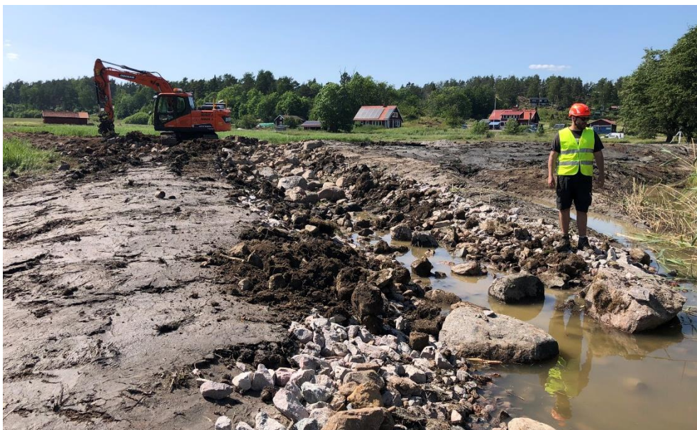
Figur 16. Bild på slutgiltigt omlöp med natursten av olika lager som översta lager. Foto: Rickard Gustafsson.
