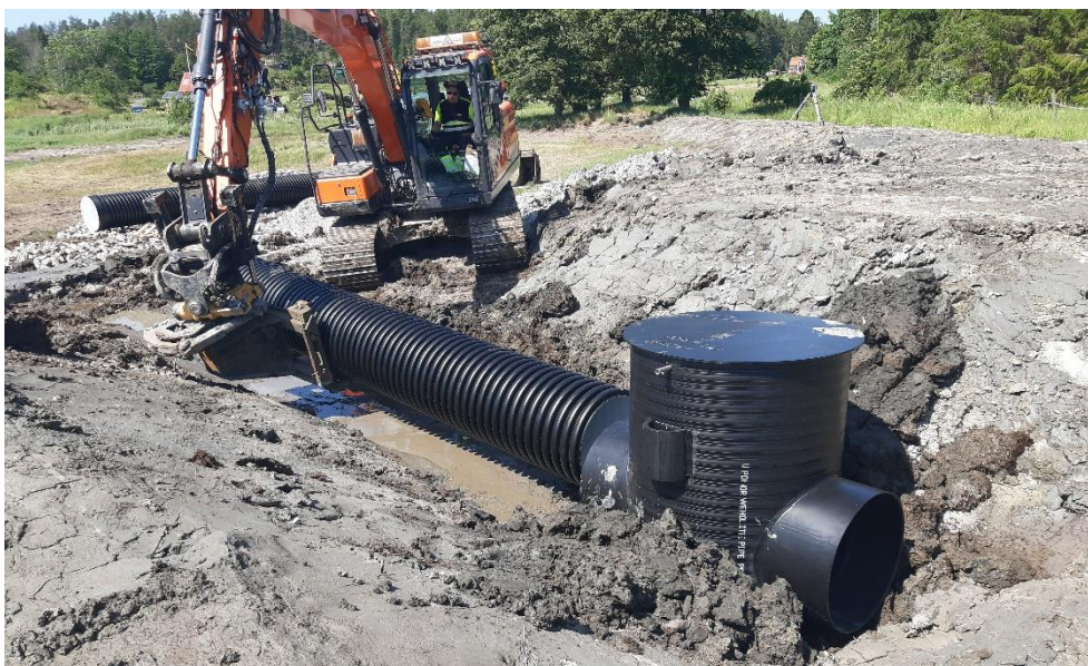
Figur 8. Regleringsmunken placerades i bäckfåran där den korsade dammvallen. Foto: Erik Johansson.
