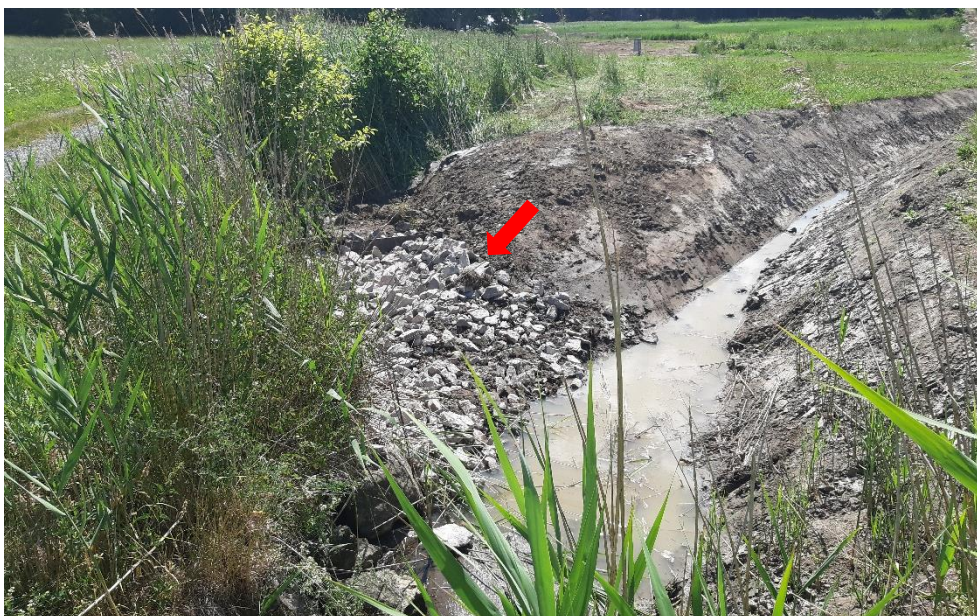
Figur 6. Där den gamla bäckfåran pluggades och erosionssäkrades (se röd pil). Foto: Erik Johansson.
