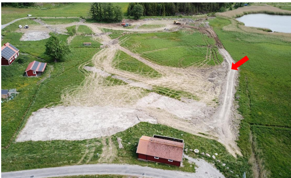
Figur 2. En dammvall (röd pil) byggdes tvärs över strandängen för att kunna hålla kvar vatten. Foto: Rickard Gustafsson.
