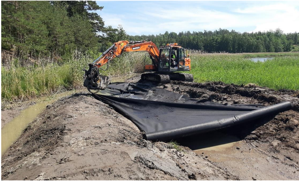
Figur 13. Geotextilduk placerades ut på schaktmassorna. Foto: Erik Johansson.
