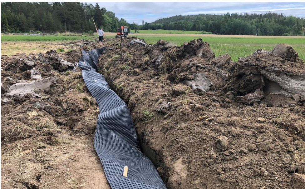
Figur 3. En platonmatta placerades centralt i dammvallen och kommer fungera som en extra tätspärr. Foto: Rickard Gustafsson.
