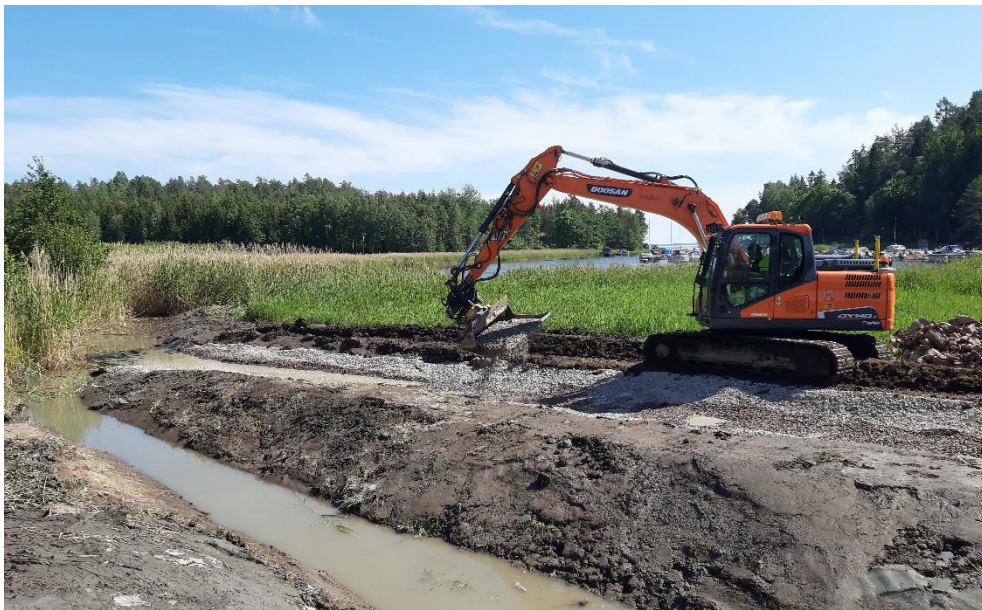
Figur 14. Stenkross placerades ut på geotextilduken. Foto: Erik Johansson.
