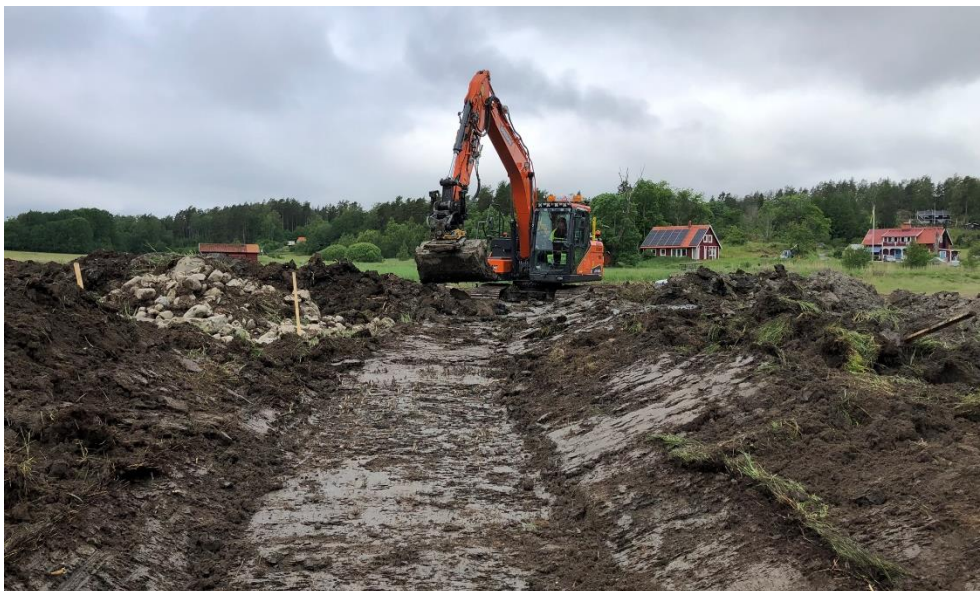
Figur 12. Faunapassagen formades av schaktmassor. Foto: Rickard Gustafsson.
